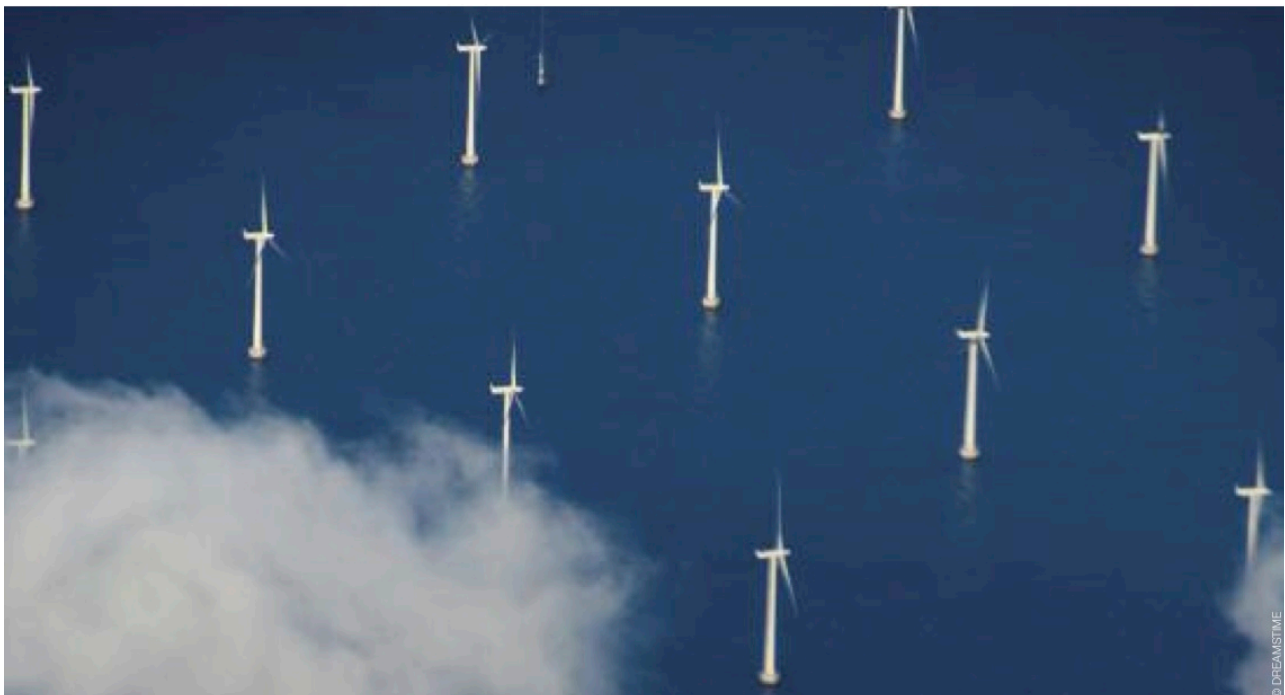
immagine Parco eolico offshore, Middelgrunden, Copenhagen, Danimarca.
